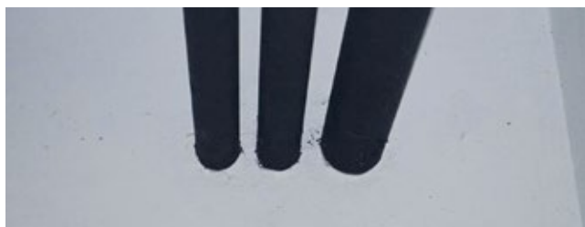
Figura 7 – Tubulações vinculadas às vagas da estrutura. A ABNT NBR 5626/1998 cita: “5.6.6.1 A tubulação não deve ser embutida ou solidarizada longitudinalmente às paredes, pisos e demais elementos estruturais do edifício, de forma a não ser prejudicada pela movimentação destes e de forma a garantir a sua manutenção”
